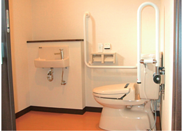
▲車いす対応のトイレ廻り
