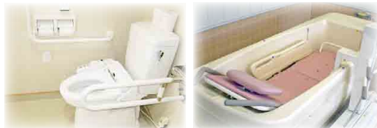
車椅子対応のトイレスペース
