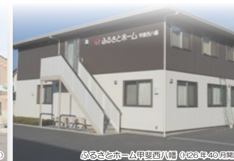
ふるさとホーム甲斐西八幡 (H26年40月開設)
