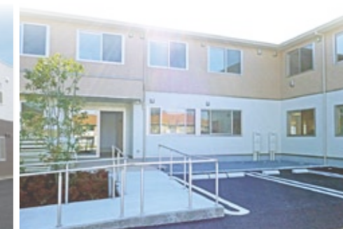
ふるさとホーム古河 (H26年3月開設)
