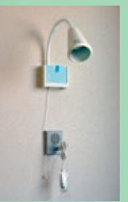
▲緊急通報装置
