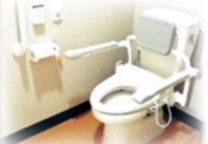
▲手すり、ナースコール付トイレ
